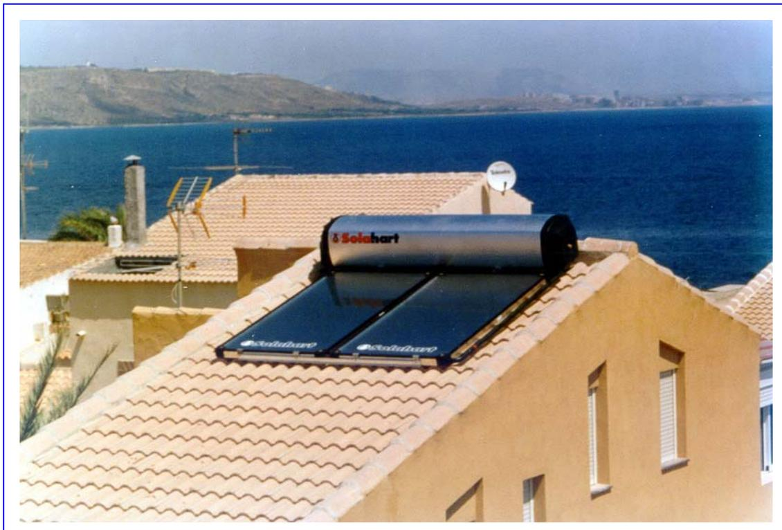
**SOLAHART** fue la pionera en el desarrollo y la utilización del circuito cerrado por termosifón para el fluido primario, logrando un elevado rendimiento operativo y elevada fiabilidad debido a la ausencia de bomba de circulación y sistema de regulación.
